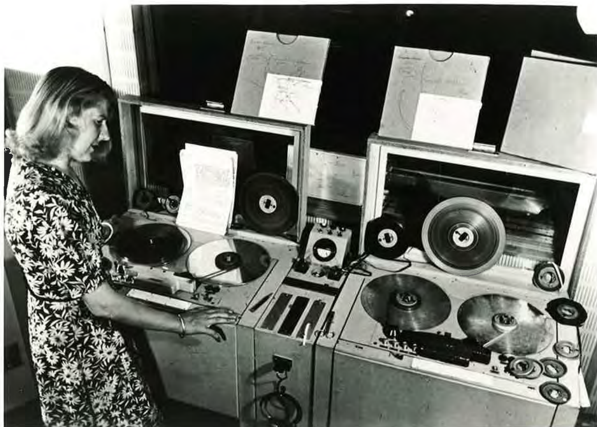
VOLLMER-Tonband M1-Lizenznachbau des AEG R23a, etwa um 1948 (Quellennachweis: Abb. 262 Li „Magnetschicht“, Seite 261 von Fe. Engel u. Co.)
