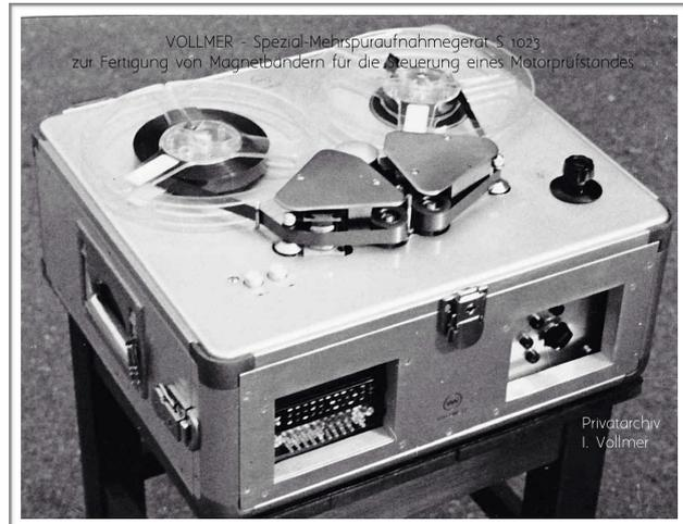
Hauptanwendung: Magnetbandherstellung zur Steuerung von Motorprüfständen, z.B. Aufzeichnung von Drosselklappenstellung, Drehzahl, Drehmoment und Temperatur. Das Gerät läßt sich mit Gurten auf jedem Fahrzeugsitz befestigen. Daneben gibt es noch Schleifenzusätze für Endlosbandschleifen verschiedener Längen - beispielsweise zur Analyse von Schwingungen, die vorher auf Geräten mit offener oder geschlossener Schleife aufgezeichnet wurden.
